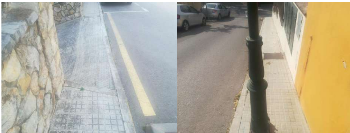
Fig. 10. Voravies del carrer des Trast inaccessible (gual i fanal)
